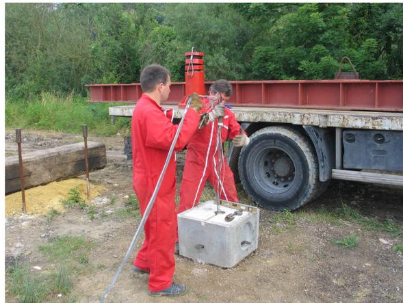
Figure 13 Mise en place de l'extensomètre amovible
