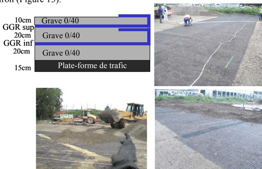
Figure 13. Plate-forme de transfert de charge du plot 4R
