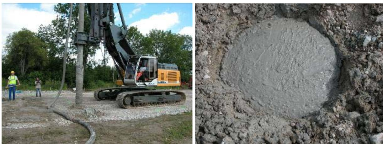
**Figure 10. Réalisation des inclusions rigides**
