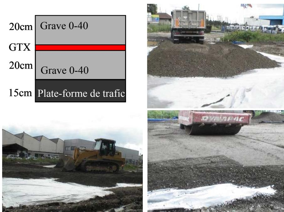
Figure 12. Plate-forme de transfert de charge du plot 3R
