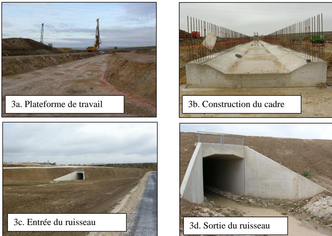
**Figure 3 – Construction du cadre béton renforcé**
