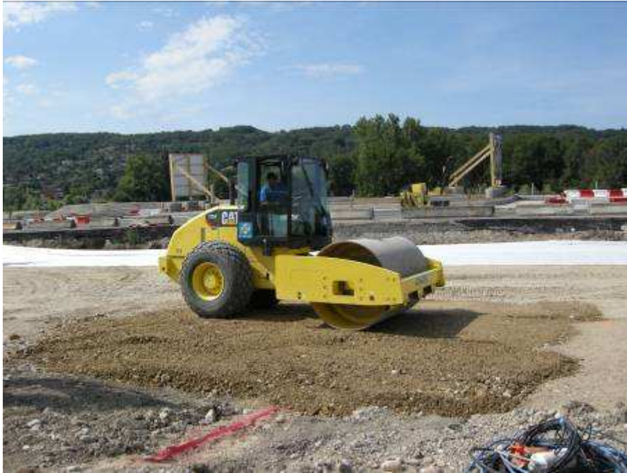
Compaction au dessus de la zone instrumentée
