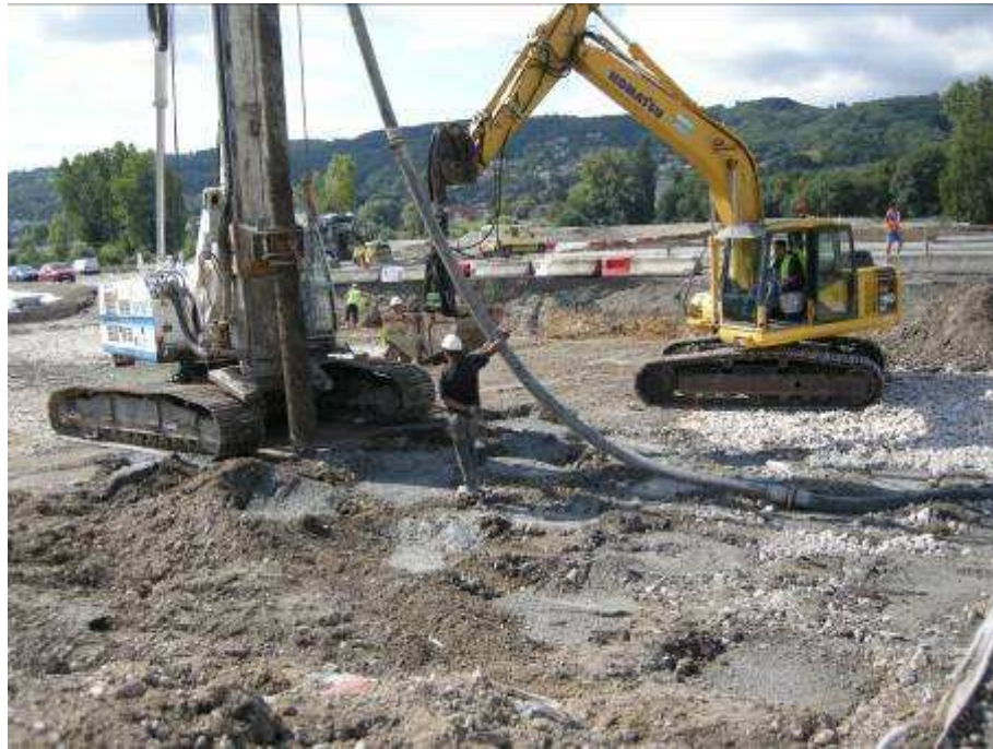
Réalisation des inclusions rigides
