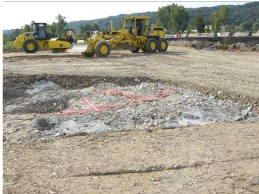
Recouvrement par 10 cm de matériau granulaire
