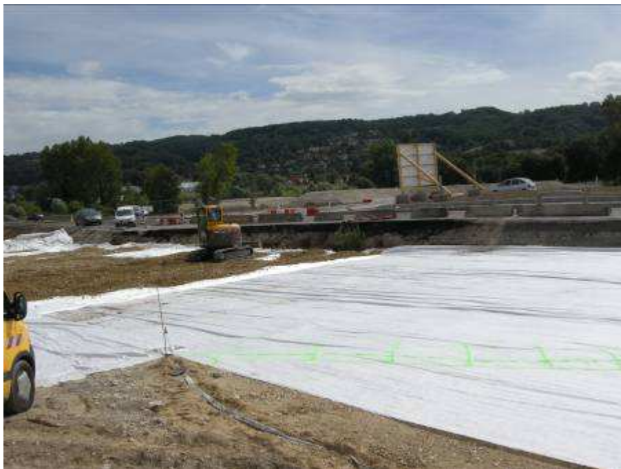
Pose des nappes géosynthétiques
