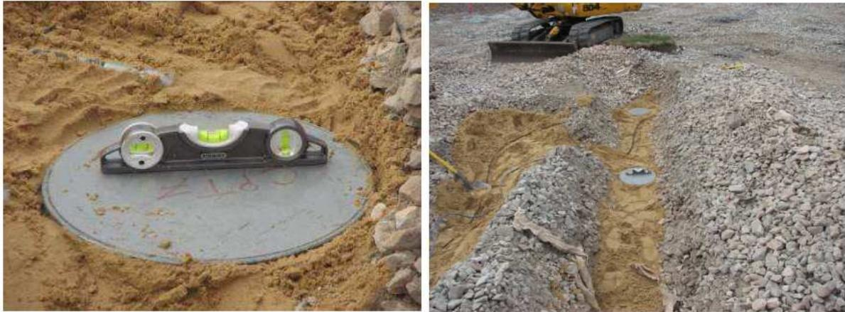
Figure 5. Capteur de pression totale
